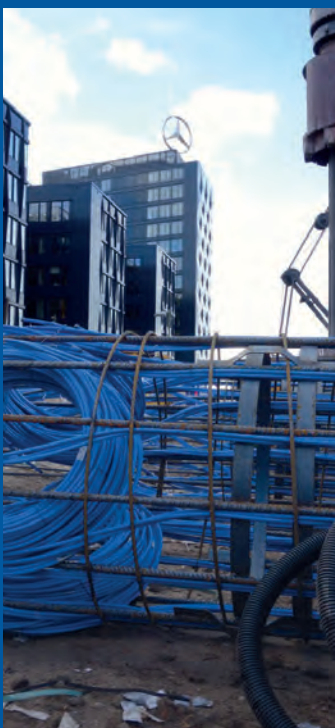
Wykop budowlany Max & Moritz, Berlin
