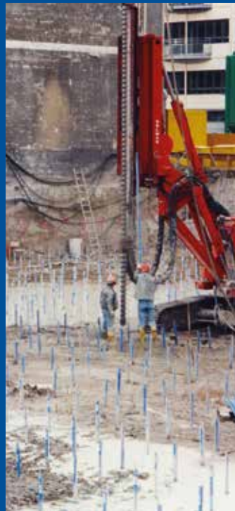
Potsdamer Platz Excavation Pit, Berlin
